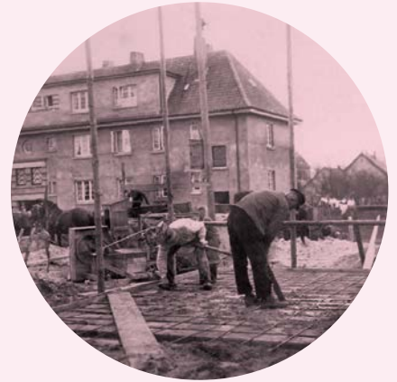
Im Haarentor war die GSG erstmals 1927 tätig. Zunächst wurde in der Von-Kobbe-Straße gebaut.
